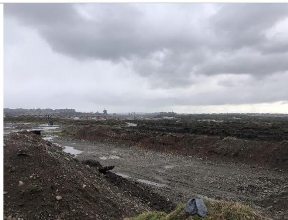
La imagen muestra como se ha modificado el tipo de sustrato rico en materia orgánica (turba) y se ha rellenado con áridos y compactado.
